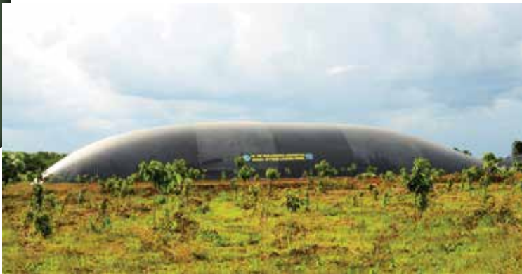
ระบบผลิตก๊าซชีวภาพขนาดใหญ่ในฟาร์มของซีพี เวียดนาม มีส่วนช่วยในการบำบัดของเสียจากปศุสัตว์และการผลิตพลังงานใหม่ ภาพ: ซีพี เวียดนาม
